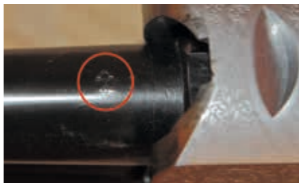
Flintenläufe mit Stahlschrotbeschuss sind mit einem eingestempelten Lilienblatt versehen.
